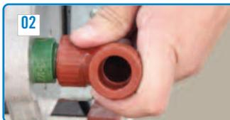
Introduzca la conexión en la boquilla macho hasta hacer tope. Cuando se haya cumplido el tiempo de calentamiento, retire la conexión de la boquilla y apóyela, sobre una superficie limpia, seca y a resguardo de corrientes de aire.
