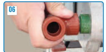
La conexión debe introducirse hasta el tope de la boquilla macho.
