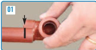
Marque en el tubo la profundidad de penetración.
