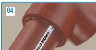
Transcurrido el tiempo de calentamiento retire el tubo e insértelo en la conexión sin pérdidas de tiempo.
